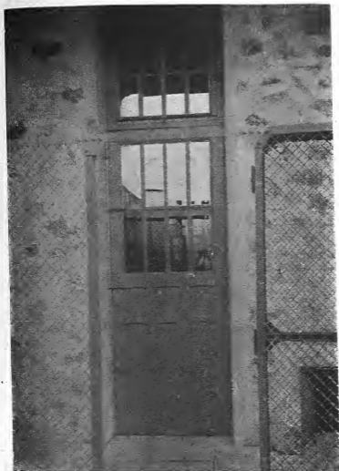
FIG. 28. — Porte extérieure des cellules (chambres d'isolement).
